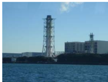
【東京電力㈱東扇島火力発電センター】
